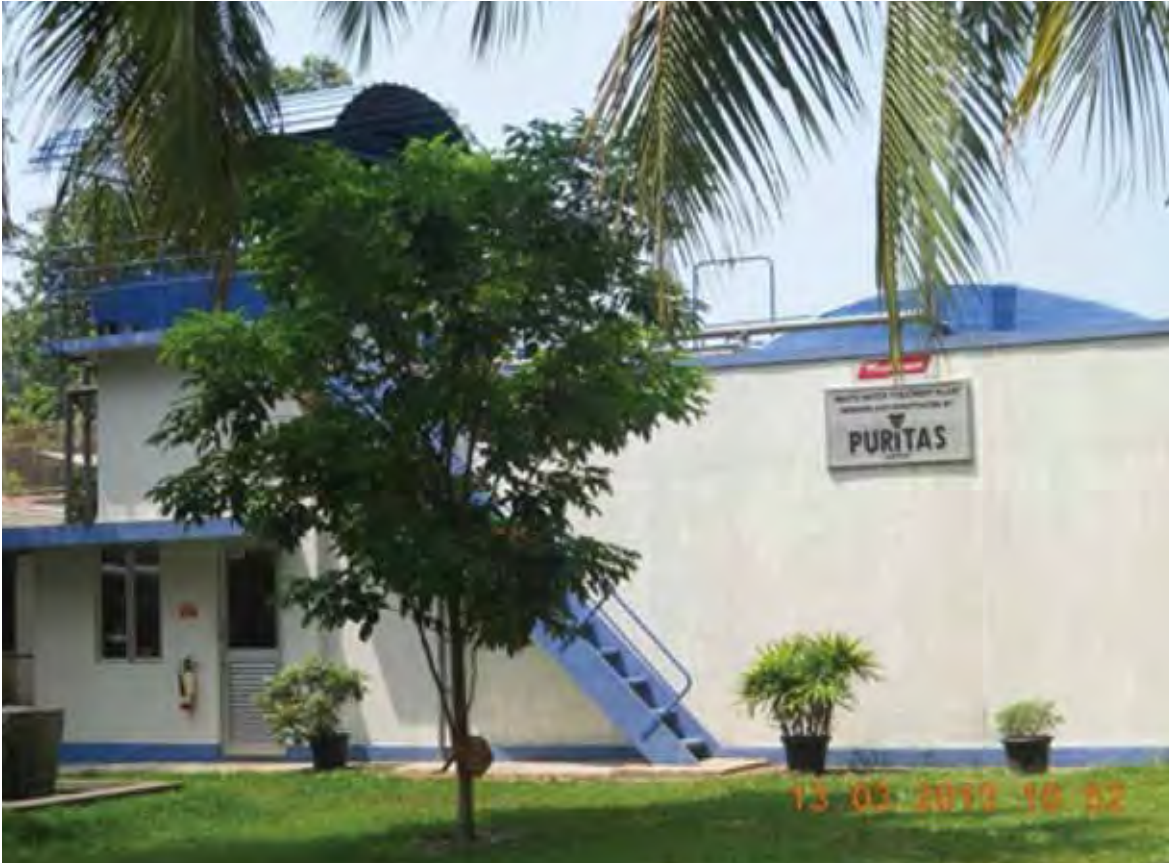
Our Effluent Treatment Plant (ETP)
